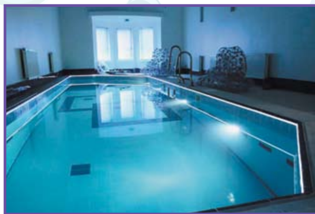
Рис. 4. Пример оптико-волоконной подсветки по периметру бассейна
